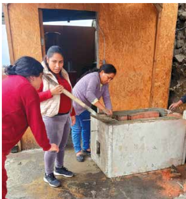
Figura 2. Encofrados para las cocinas y ensamblaje en el sitio por las propias madres
